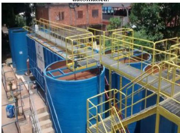
Figura 4 - Construção de nova ETA modular automática.
