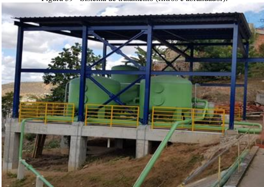
Figura 59 - Sistema de tratamento (filtros e abrandador).
