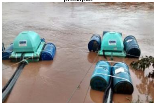
Figura 10 - Instalação dos flutuantes na captação principal.
