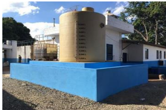
Figura 7 - Construção de contenção de químicos.
