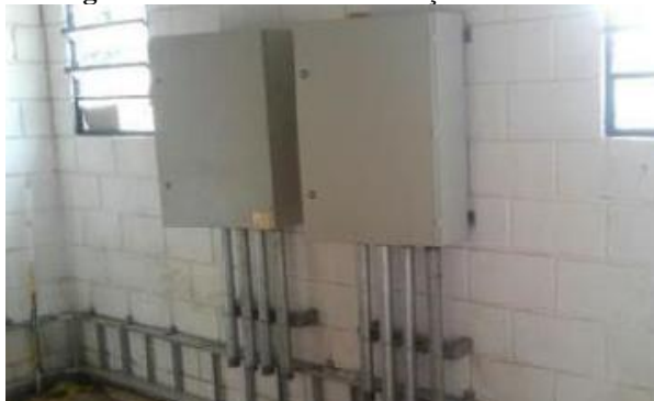
Figura 12 - Painéis de distribuição 220V e 440V.
