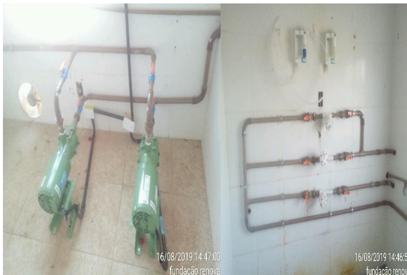
Figura 61 - Reforma do sistema de cloro gasoso.
