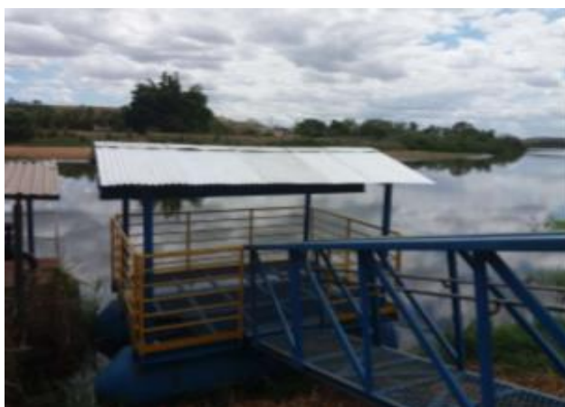
Figura 37 - Construção de nova balsa de captação.
