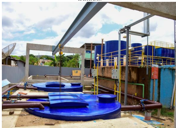
Figura 22 - Revitalização do reservatório de água tratada.
