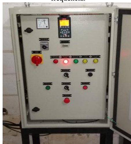
Figura 15 - Painel de acionamento com inversor de frequência.
