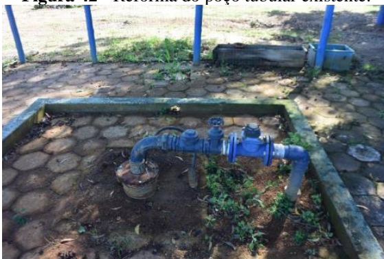
Figura 42 - Reforma do poço tubular existente.
