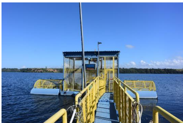
Figura 40 - Balsa com 3 bombas, sendo 1 reserva.
