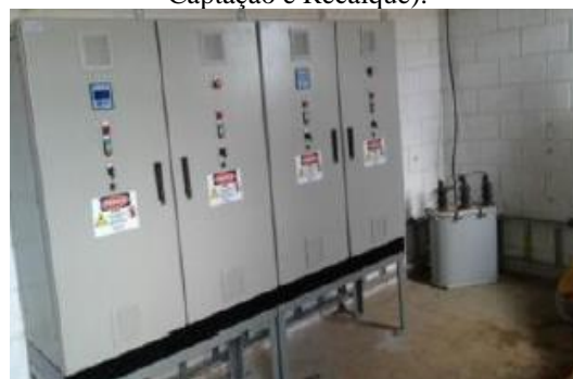
Figura 11 - Painéis com Inversores (Bombas da Captação e Recalque).
