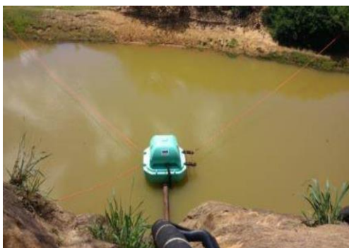
Figura 16 - Flutuante com duas bombas (1 reserva).
