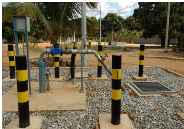
Figura 23 - Poços instrumentados como captação alternativa.
