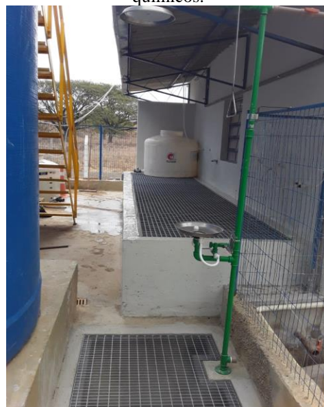
Figura 36 - Construção de contenção para produtos químicos.
